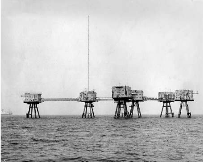
Vues de l'antenne de Radio City
