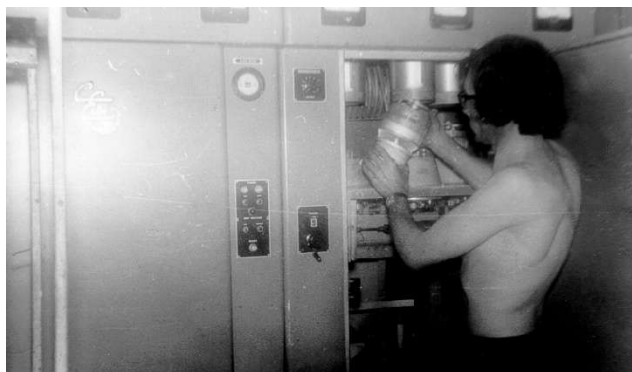
Ci-dessus, placement d'un tube final 4CX5000. Il y en avait 4 par émetteur. Modulation écran par 4 tubes 4-65A.
