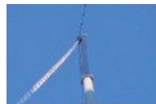
"Plastic sur métal" - Utilisation d'une extension en PVC sur un mât en métal. Notez que la section verticale est tenue à l'écart du mât.
