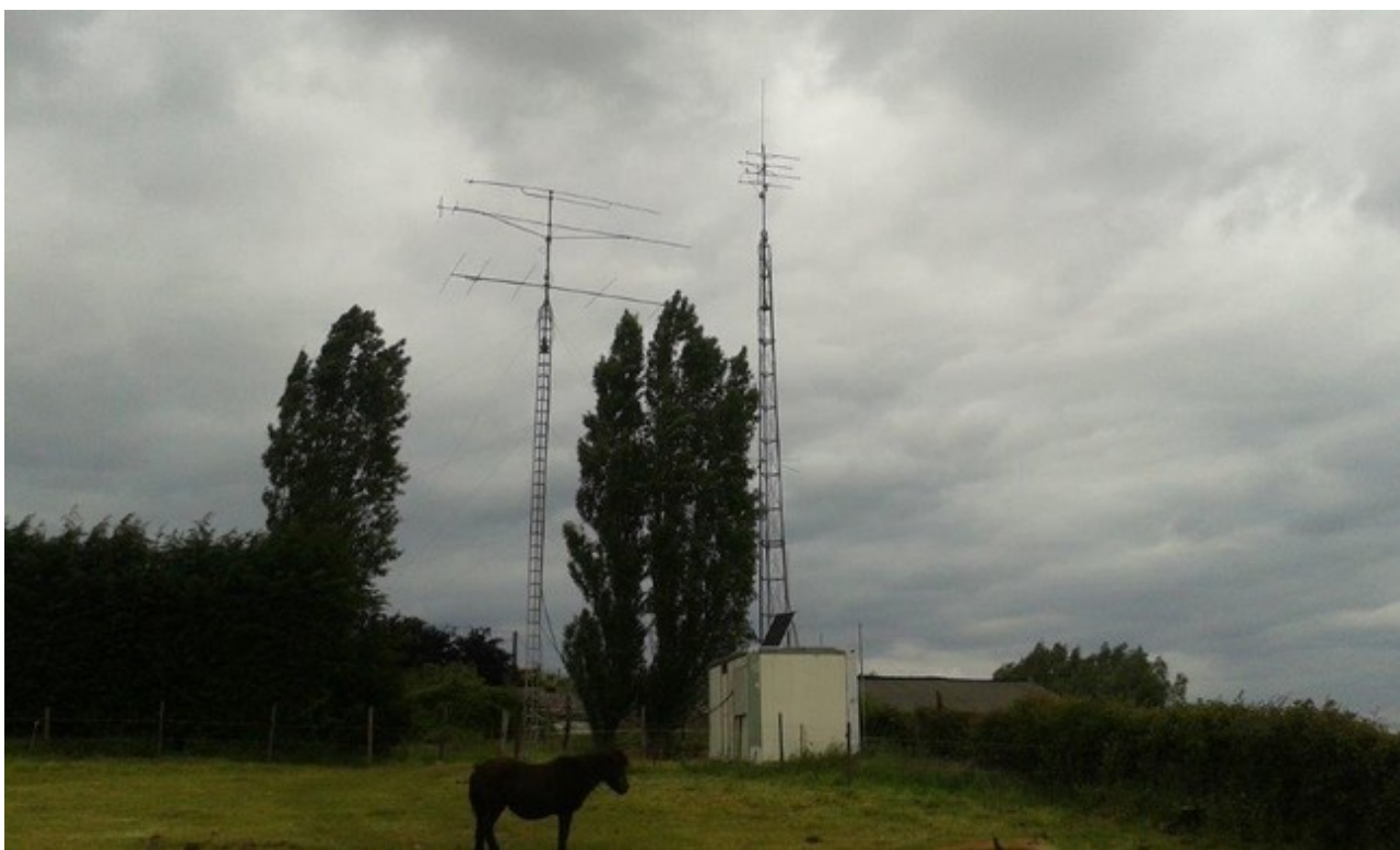
Le shack et les antennes VHF/UHF/SHF au « Trou du Bois » On y voit également le panneau solaire qui alimente ONØWTO
