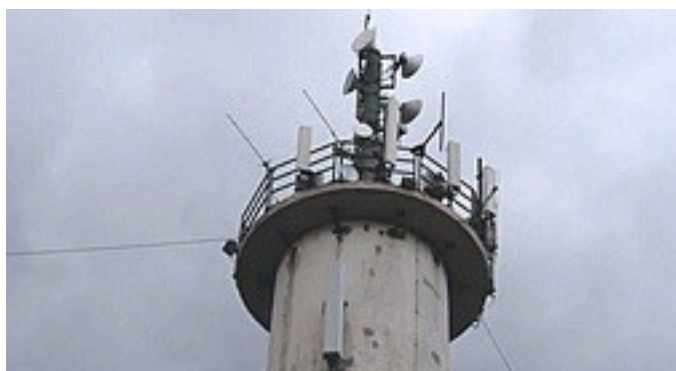
La tour en béton pour Vodafone et les antennes FM (capture de la vidéo)
